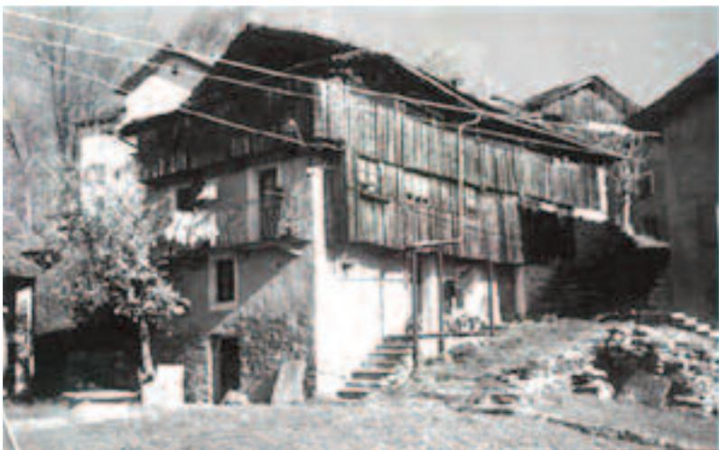
CASA WALSER A 4 PIANI (fraz. Sella) - I primi due piani (stalla e parte abitativa) sono in muratura, i soprastanti presentano all'interno ancora la struttura in blockbau. Al terzo piano probabilmente le lobie in legno sono state sostituite dalla muratura in un secondo momento.
