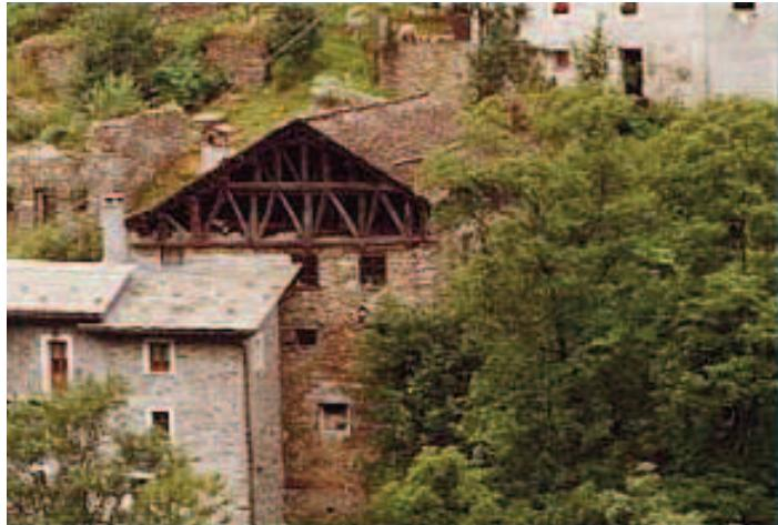
CASA WALSER (fraz. Roncaccio Inferiore) - Sul lato a valle la travatura del tetto è costituita da una struttura a campate a tre tronchi su due livelli.
