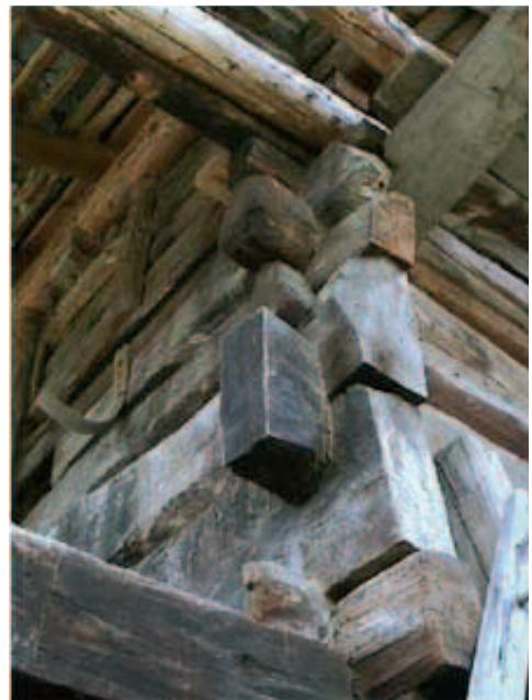
**STRUTTURA A BLOCKBAU A TRONCO INTERO** - Travi orizzontali portanti a tronco intero.
