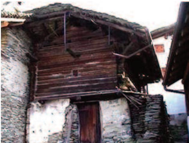
CASA A BLOCKBAU (San Gottardo) - Ben visibile in questa vecchia casa la struttura a blockbau perfettamente conservata; probabilmente i tronchi sporgenti sostenevano la lobia.
